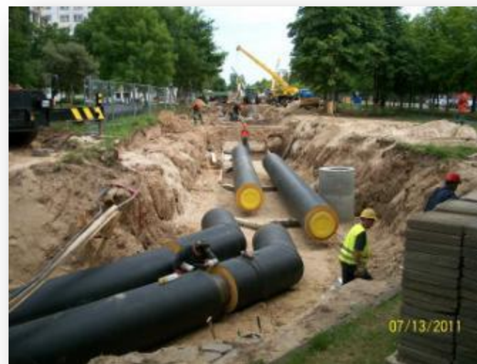
Šilumos tramos nuo ŠK-73 iki ŠK-ST-1 modernizavimas Statybininkų g., Panevėžys (projekto vertė 2,7 mln. Lt )
